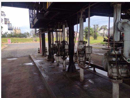
Foto 3: área de acesso a caminhões tanque
