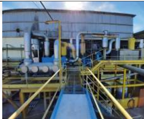
Figura 02: Lavadores de gases da fábrica de farinha e óleo.
