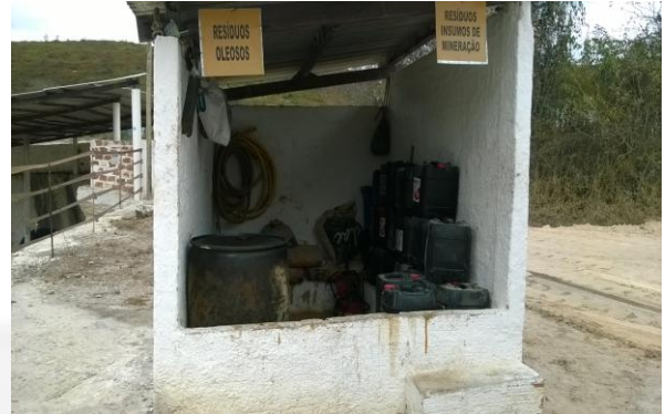
Foto 8. Depósito de resíduos oleosos.
