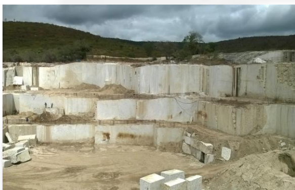
Foto 1. Frente de lavra a ser ampliada.
