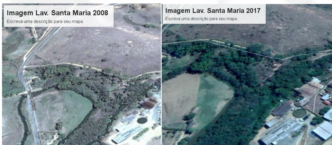
Figura: 03 – Vista da área do empreendimento, com as estruturas presentes na APP do curso d'água por ocasião da regularização da intervenção e as mesmas estruturas atualmente. Fonte: Google Earth.
