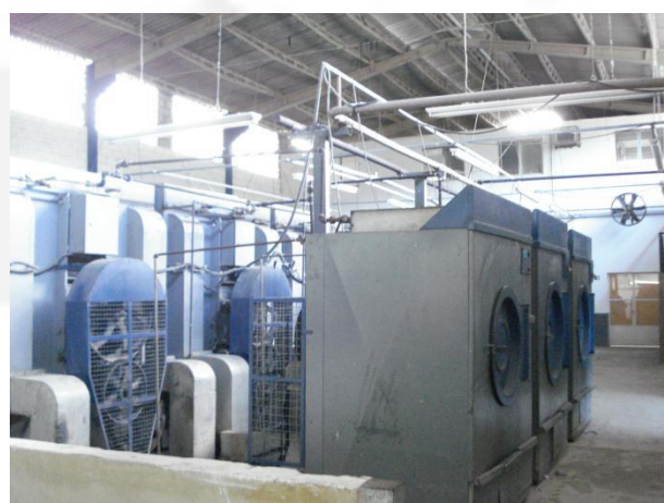
Foto 04. Área interna do galpão
