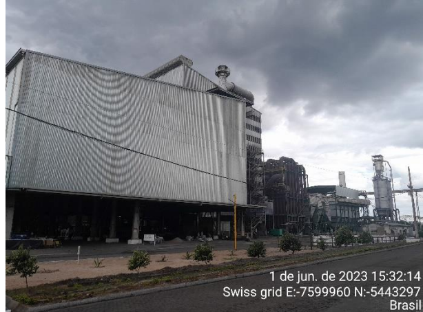
Foto 02: Sistema de despeiramento de forno.
