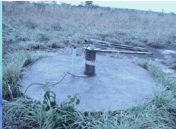
Foto 02. Poço tubular
