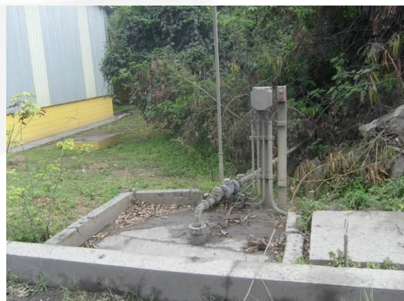
Foto 04. Poço Tubular.
