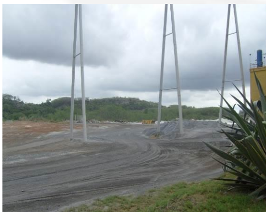
Foto 03. Área antropizada onde será a instalação.
