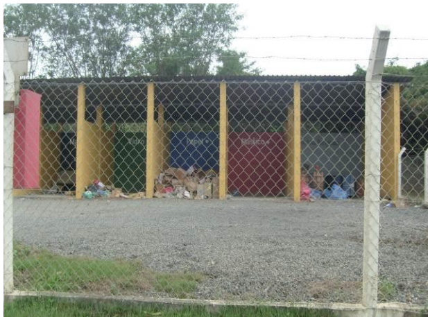
Foto 05. Armazenamento Temporário de Resíduos Sólidos
