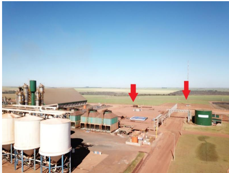
Foto 03. Outro ângulo do local de instalação dos equipamentos
