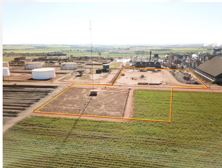
Foto 02. Local de instalação dos equipamentos da planta de etanol de milho
