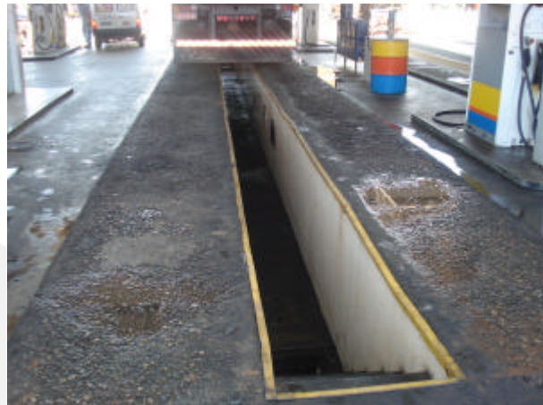
Foto 02. Área de troca de óleo para caminhões.
