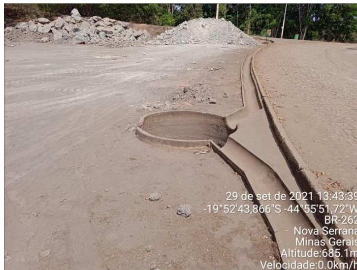
Foto 06: Canaletas de drenagem pátio de escória
