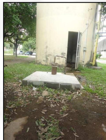
Foto 04: Piso sanitário ao redor do poço tubular.
