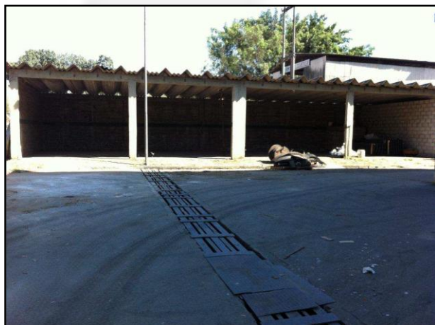
Foto 03: Depósito de Armazenamento temporário de resíduos.
