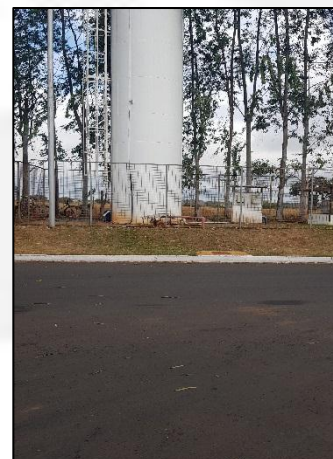
Figura 4: Caixa d'água e horímetro do poço tubular.
