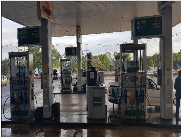
Figura 1: Pista de abastecimento de veículos de pequeno porte.
