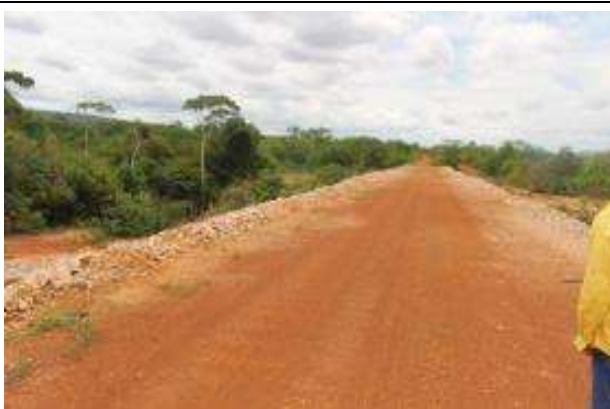
Foto 04. Adequação de estradas
