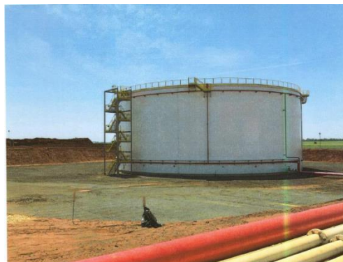
Foto 04. Novo reservatório de etanol (25.000m³)
