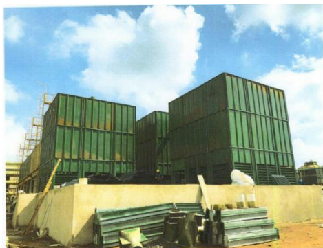
Foto 03. Nova torre de resfriamento destilaria.
