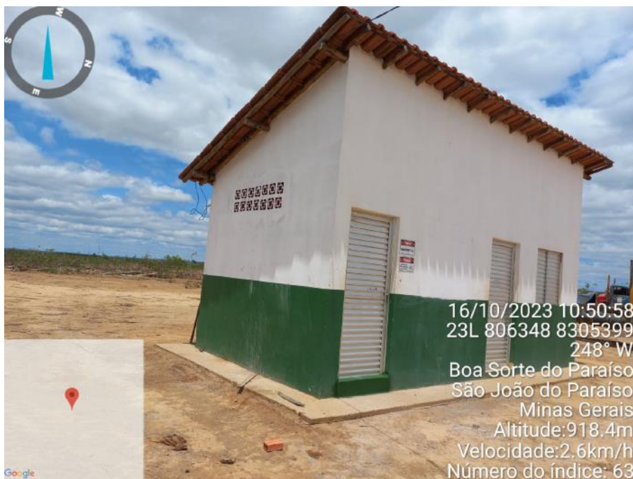
Figura 17 - Depósito de armazenamento de produtos e embalagens vazias, de agrotóxico.
