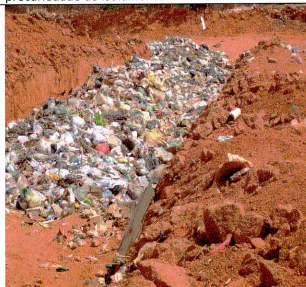
**Foto 3:** Vala em operação, pode-se observar a ausência de recobrimento.
