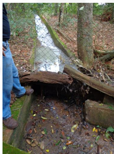
Figura 10. Canal de drenagem da água pluvial obstruído (registro em 23/01/2015)
