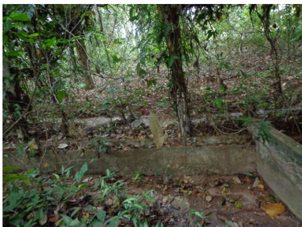
Figura 11. Água residuária percorrendo por fora do canal impermeabilizado (registro em 23/01/2015)
