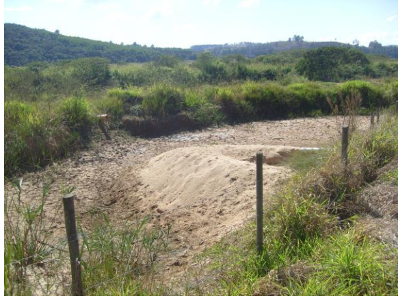
Foto 4: Bacia de decantação.
