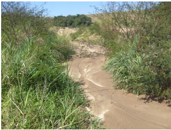
Foto 5: Sistema de drenagem.
