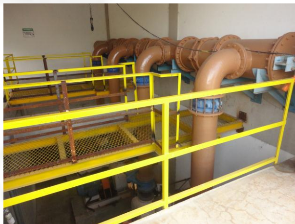
Foto 08. Elevatória de esgoto bruto.
