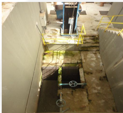
Foto 07. Tratamento Preliminar - Gradeamento
