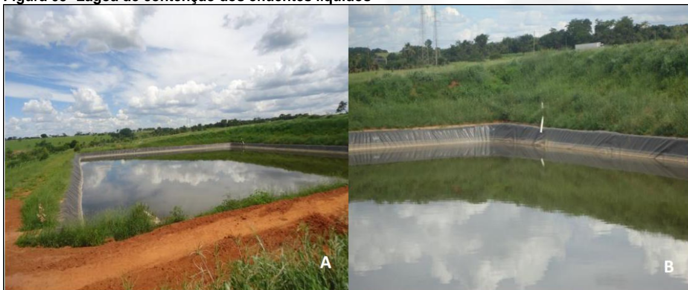
Figura 05- Lagoa de contenção dos efluentes líquidos
