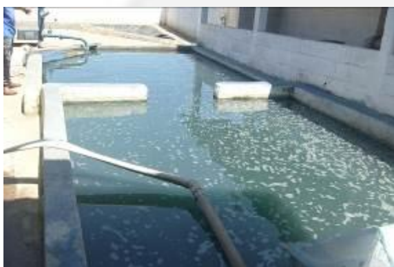
Foto 15: Tanque de passagem.
