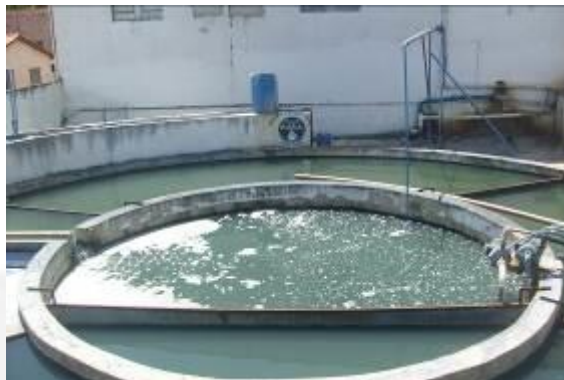
Foto 14: Tanque de decantação.
