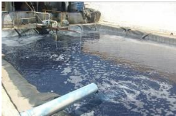
Foto 13: Tanque de homogeneização.
