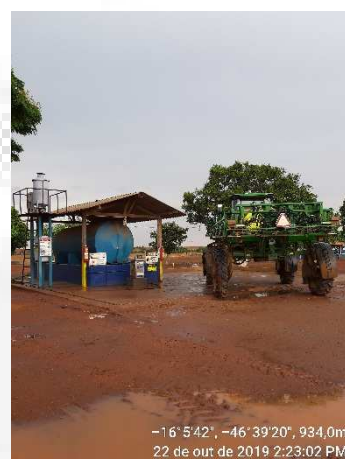
Foto 04. Posto de abastecimento de combustíveis
