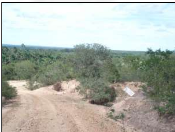
Foto 19. Bacia de contenção de água pluvial.
