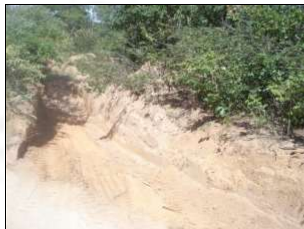
Foto 20. Bacia de contenção de água pluvial.
