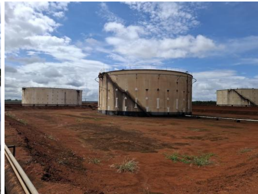
Foto vistoria: Tanques de Etanol
