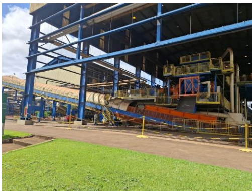
Foto Vistoria: Área industrial
