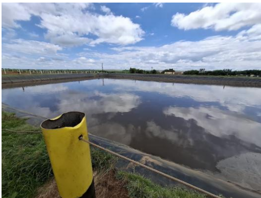
Foto Vistoria: Reservatório de água
