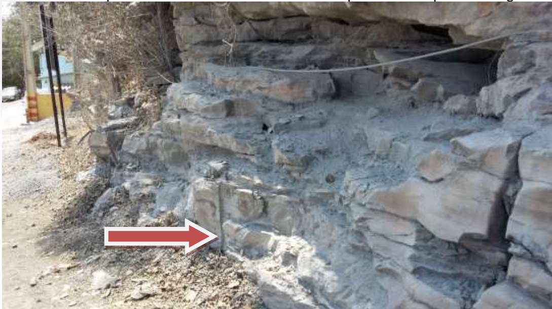
Foto 04: Resquíio de furo de desmonte de rocha próximo a Lapa da Barriguda.
