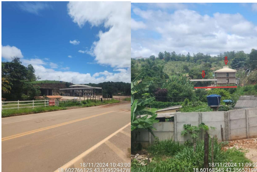
Figura 4: Posto do Serro, em instalação, localizado na mesma cota da pista de rolamento da rodovia BR-259 (ponto de visada oeste) e alteado (linha reta vermelha) em relação ao talvegue de suposto curso d'água (ponto de visada leste)
