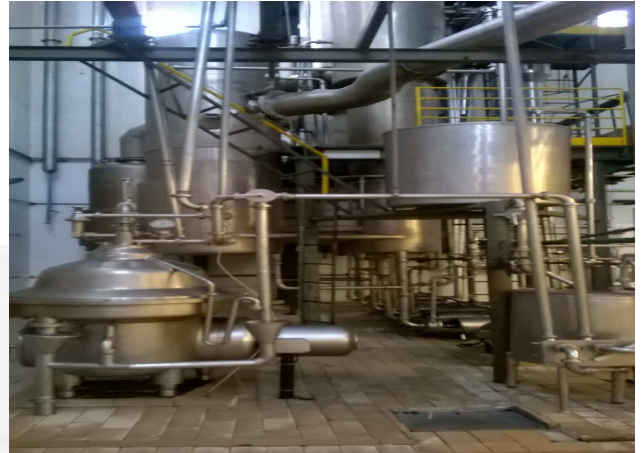
Foto 02. Interior da fábrica
