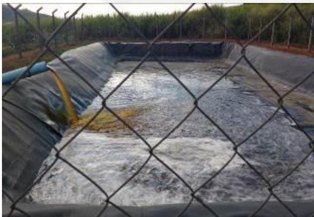
Foto 03. Lagoa de armazenamento de Efluente Industrial
