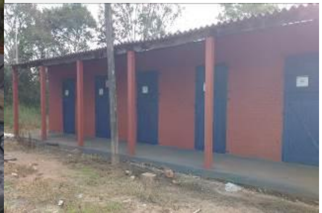
Foto 04. Depósito Temporário de Resíduos Sólidos
