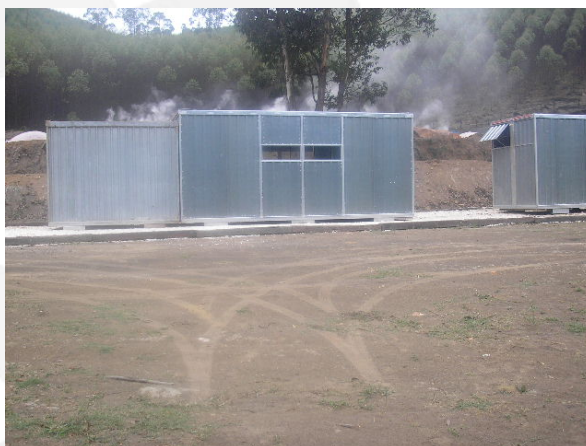
Foto 04 – Refeitório, sanitários e vestiários na área de carvoaria.
