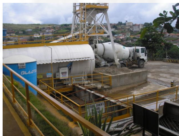
Foto 04. Visão da planta da Central Beton
