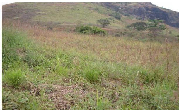
Figura 04 – Detalhe da área do bota fora da Casa de Força.
