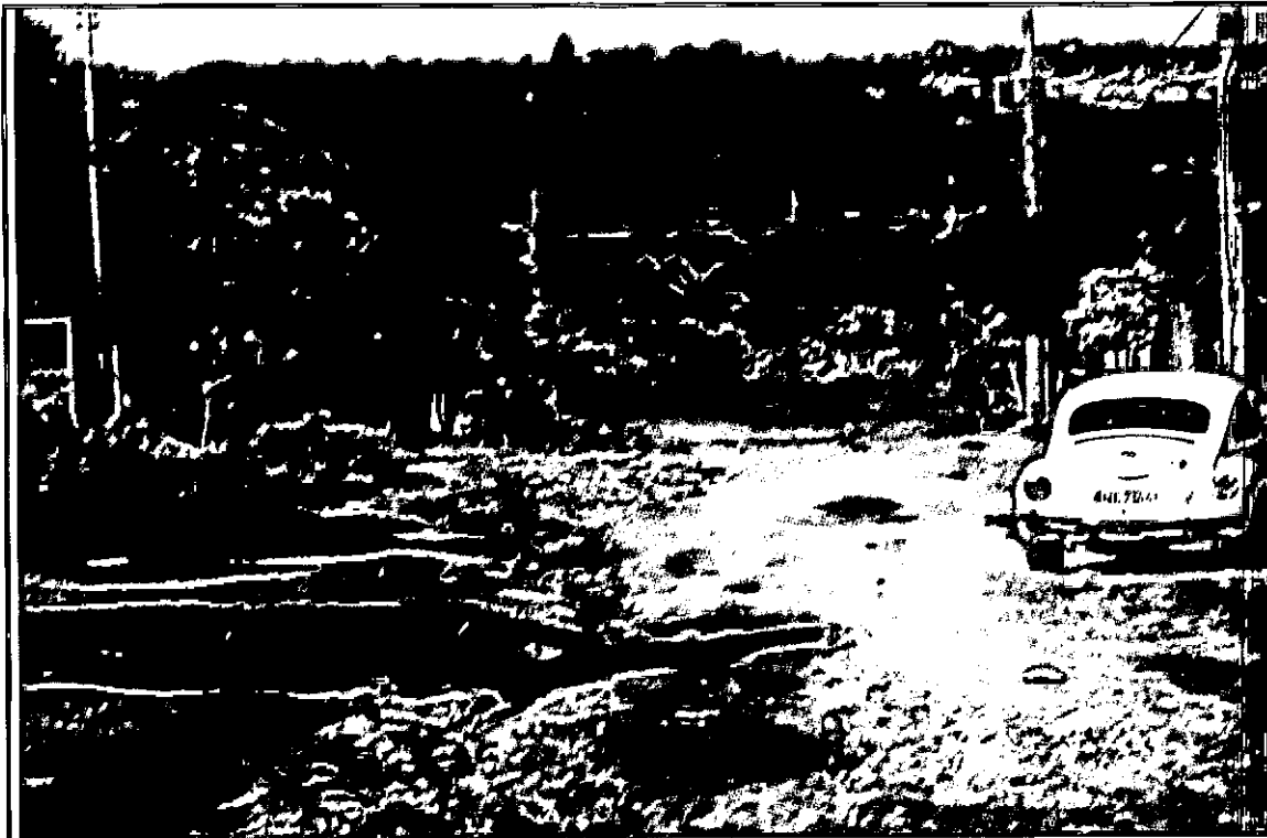
Foto- 56 – Erosão em uma das ruas do bairro São Caetano
