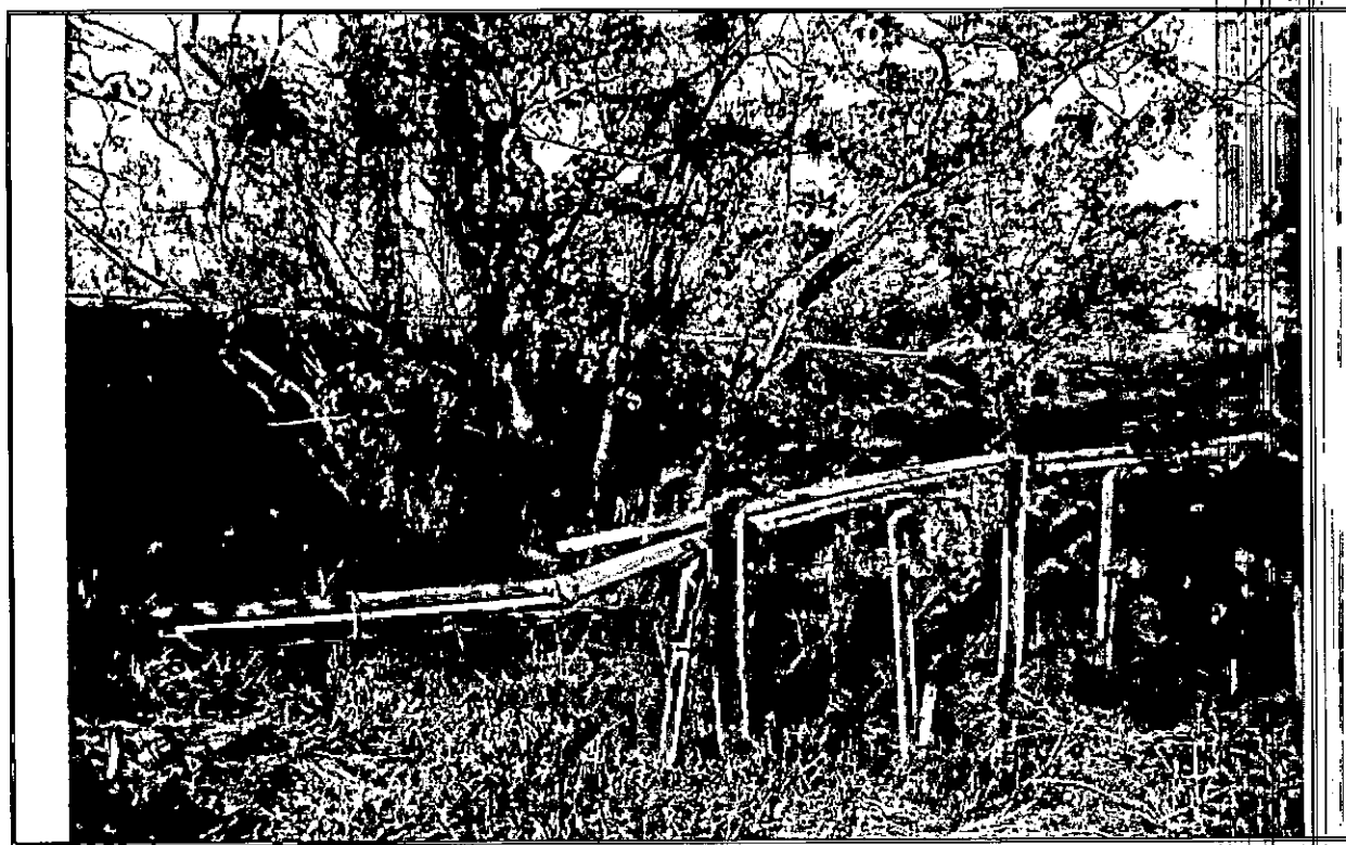
Figura 24 - Interceptor de esgoto Bairro Belvedere
