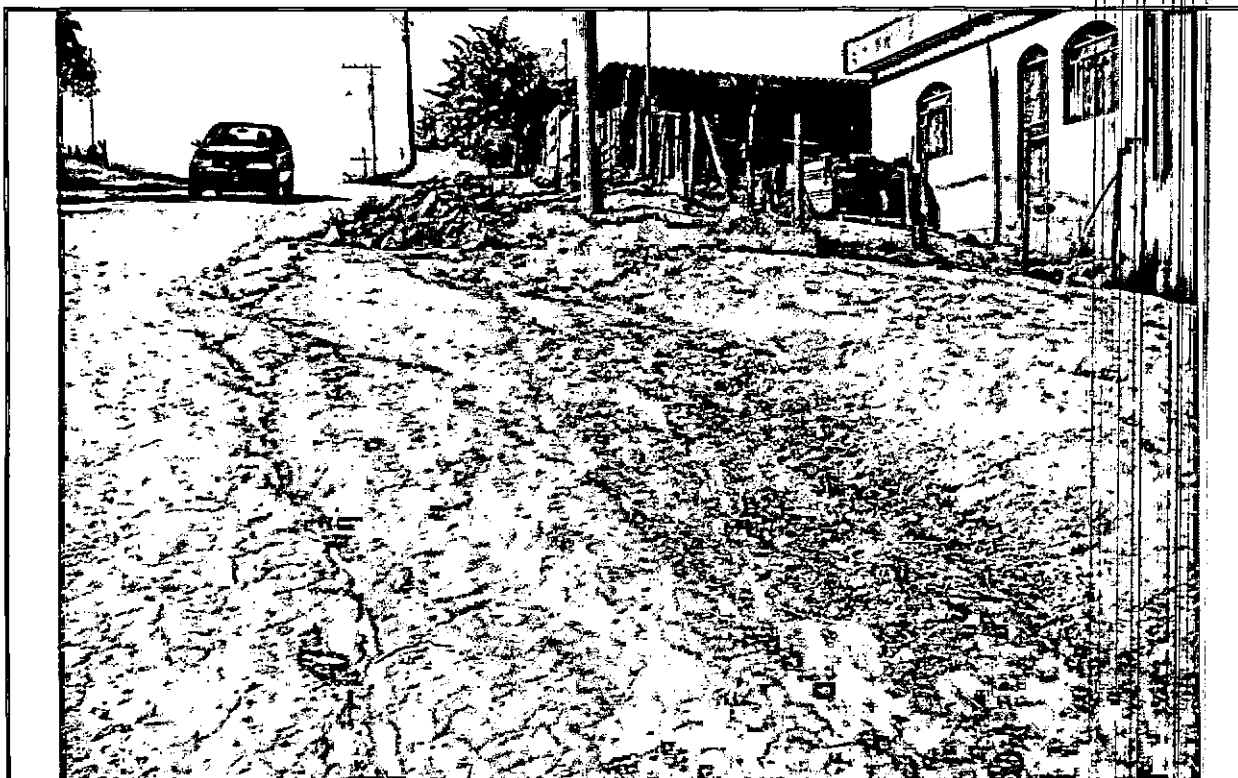
Figura 03 – Rua desprovida de coleta de esgoto sanitário – Bairro Floresta
