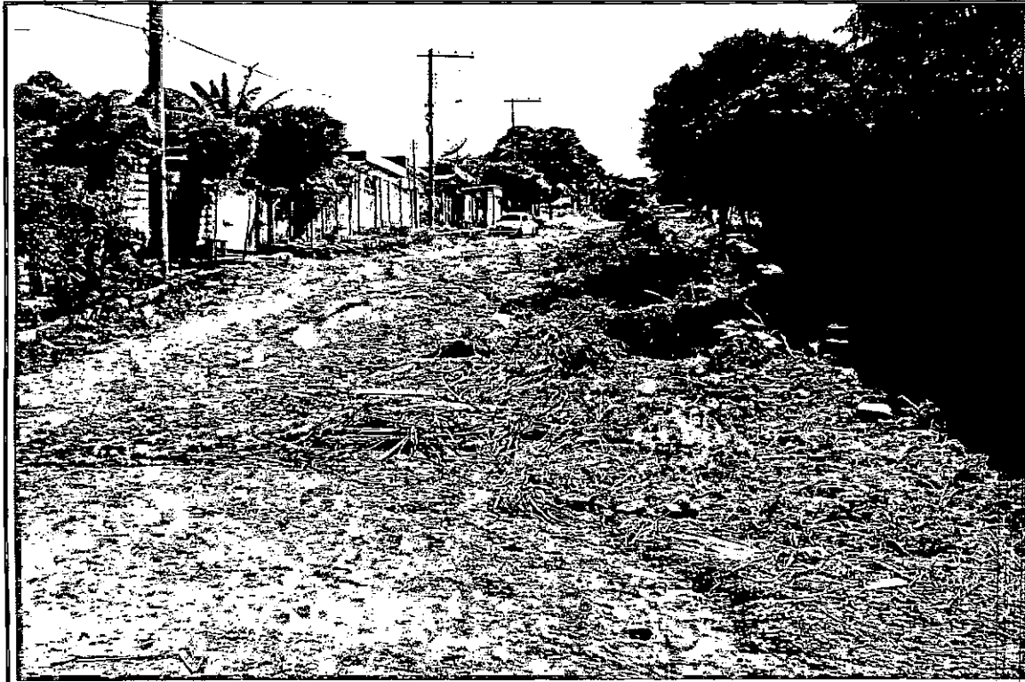
Foto- 57 – Vista de uma das ruas do bairro São Caetano
