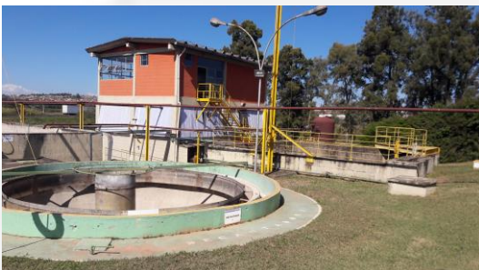
Vista geral da estação de tratamento de efluente industrial - ETEI
