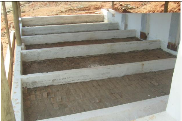
Foto 4. Leito de secagem do lodo da ETEI
