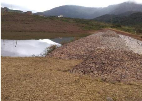
Foto 3. Dique de Contenção de Sedimentos
