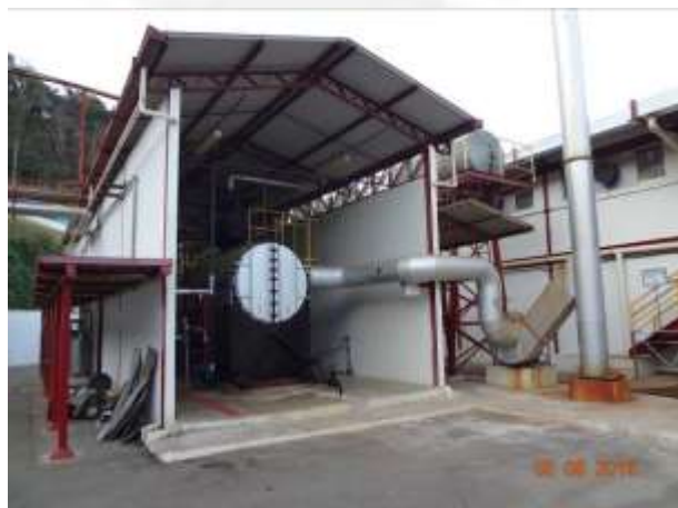
Fig. 3 – Chaminé da caldeira
