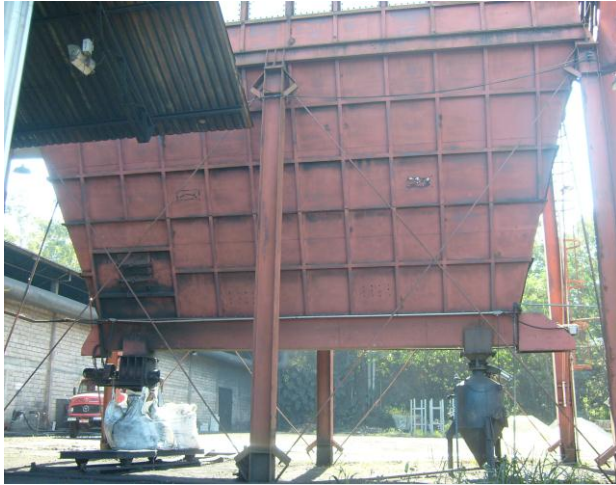
Foto 03. Filtro de mangas da descarga de carvão
