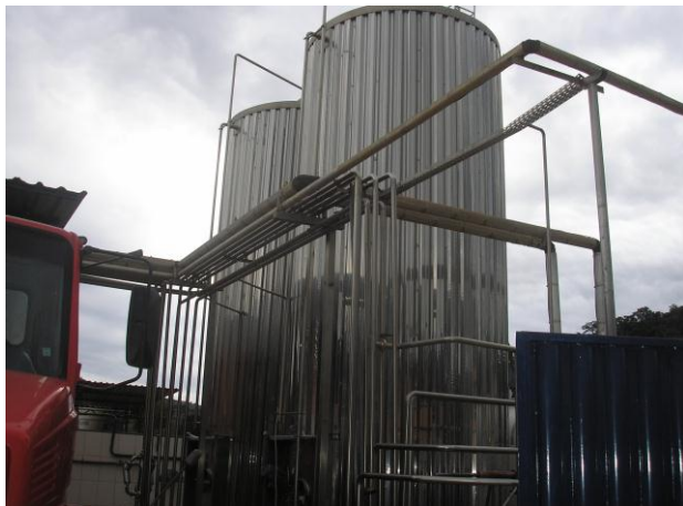
Foto 01. Silos para armazenagem de leite e soro
