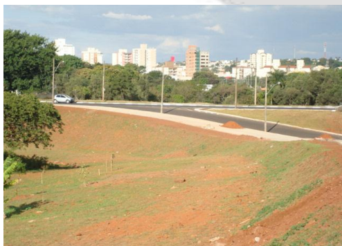
Figura 3. Execução de passeio, ciclovia e plantio de grama em extensão do talude.
