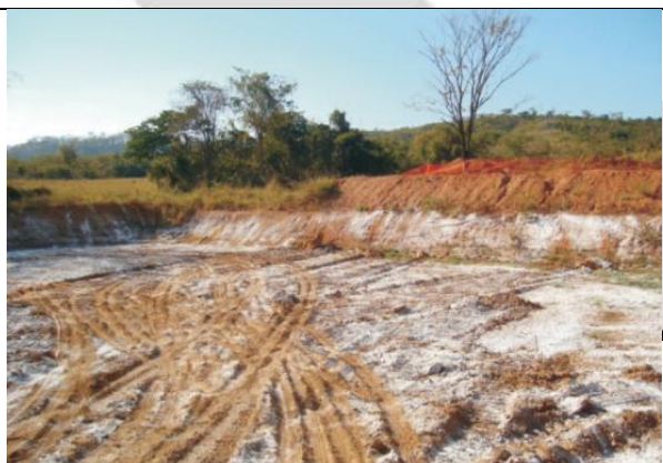
Foto 01. Processo de desinfecção das lagoas de estabilização.
