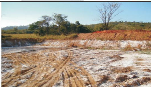
Foto 16. Processo de desinfecção das lagoas de estabilização.
