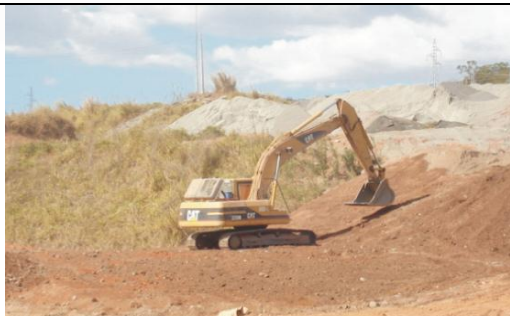
Foto 14. Conformação dos taludes da área do britador.
