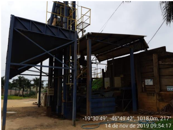
Figura 11. Planta de lavagem de grãos de café (separação via úmida), a ser desativada
