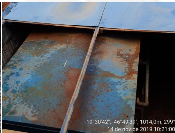
Figura 2. Caixa Separadora de Água e óleo - CSAO
