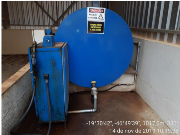
Figura 7. Bacia de contenção no tanque de abastecimento de combustível
