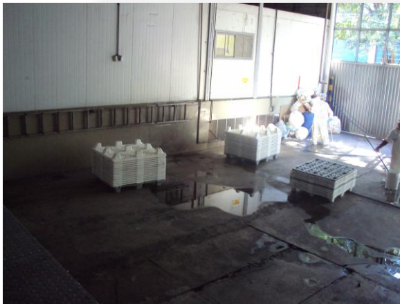
Foto 1: Pátio de recepção
