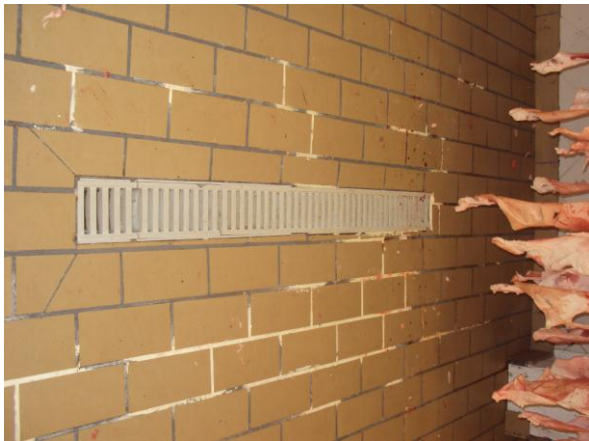
Foto 5: Canaletas internas ao empreendimento
