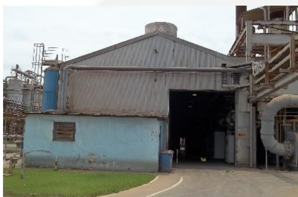
Foto 01. Caldeiraria que será desativada.
