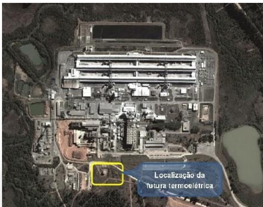
Figura 01: Área prevista para instalar e operar a usina termoelétrica.
