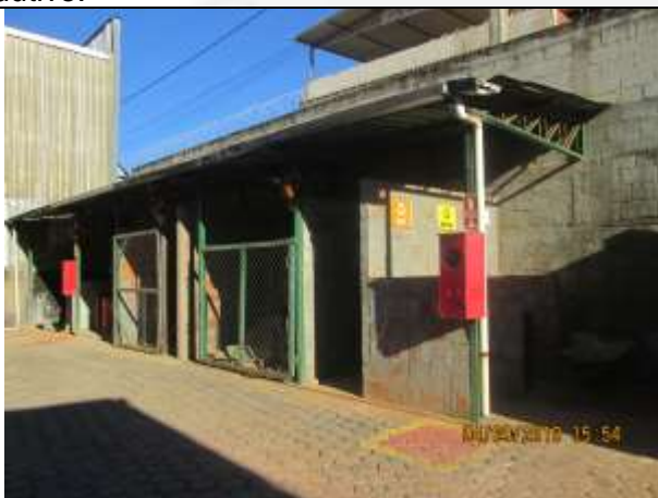
Foto 7. Depósito temporário de resíduos.
