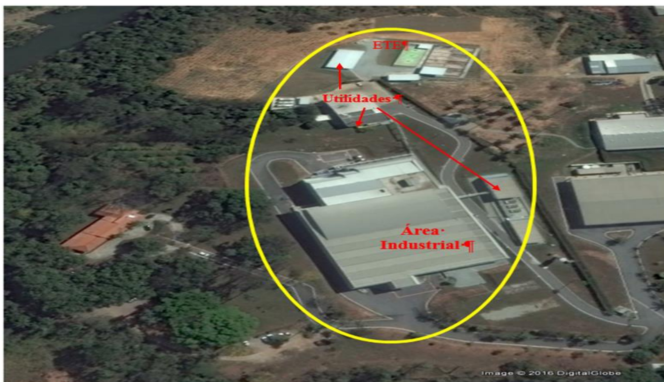
Figura I - Imagem atualizada do empreendimento com a visualização do entorno em amarelo e principais instalações.
