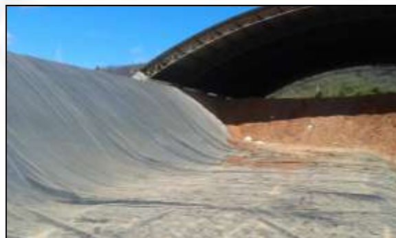
Foto 10 – Impermeabilização e cobertura do aterro
