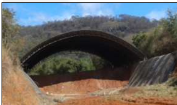
Foto 9 – Área do Aterro Industrial
