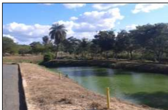
Foto 3 – Lagoa de acumulação (ETE)
