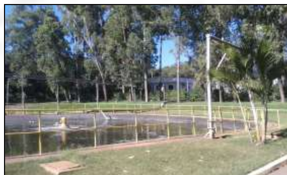
Foto 2 – ETE Industrial e Sanitária
