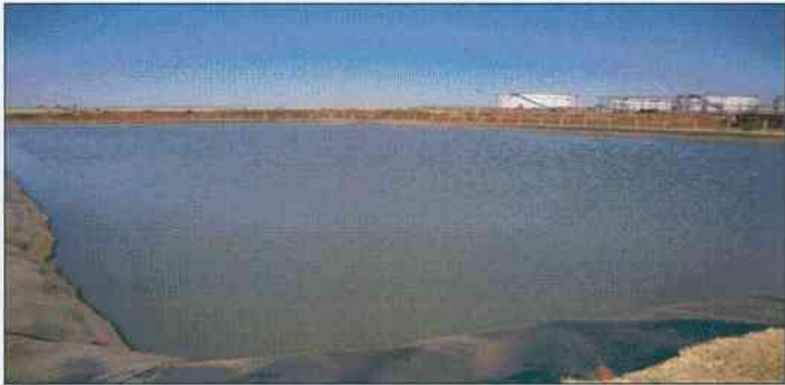
A imagem demonstra que o reservatório de águas resíduárias além de apresentar uma impermeabilização por meio de uma manta de PEAD - Polietileno de Alta Densidade, também possui todos os controles implementados, conforme previsto na Deliberação Normativa COPAM nº 164/2011.
