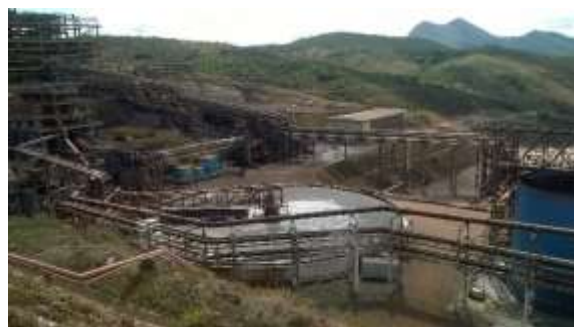
Foto 02: Planta de beneficiamento
