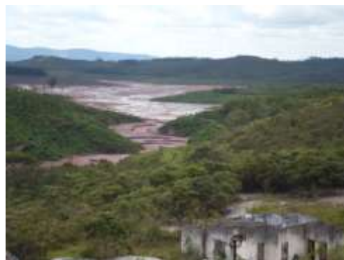
Foto 06: Barragem de rejeitos
