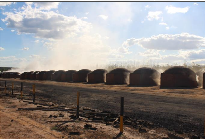
Foto 10: Vista da Planta Instalada
