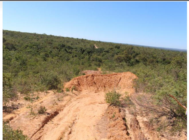
Foto 08: Bacias de contenção
