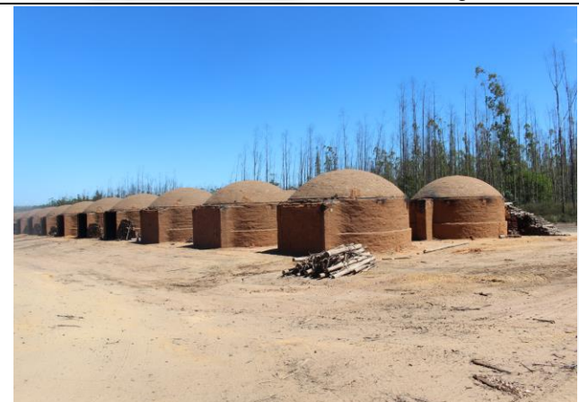
Foto 09: Vista da Planta Instalada
