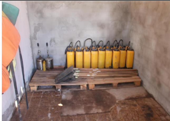
Foto 05: Material Brigada de Incêndio
