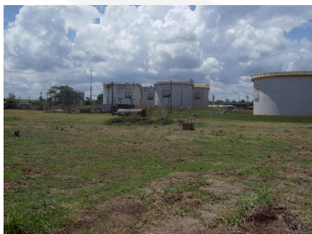
Área de instalação dos tanques.
