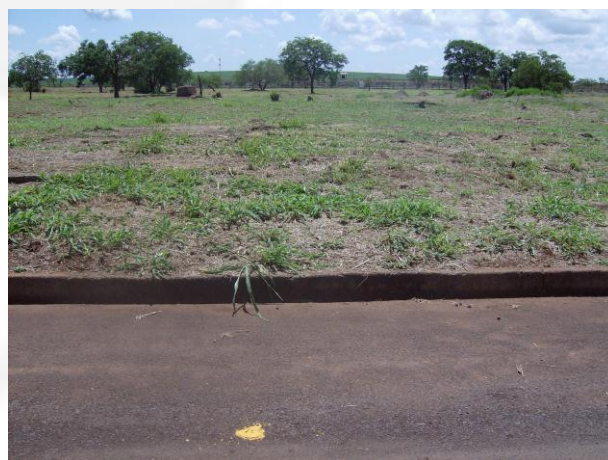
Área de instalação dos tanques
