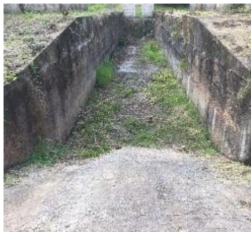
Foto 02. Baia para lama dos altos fornos
