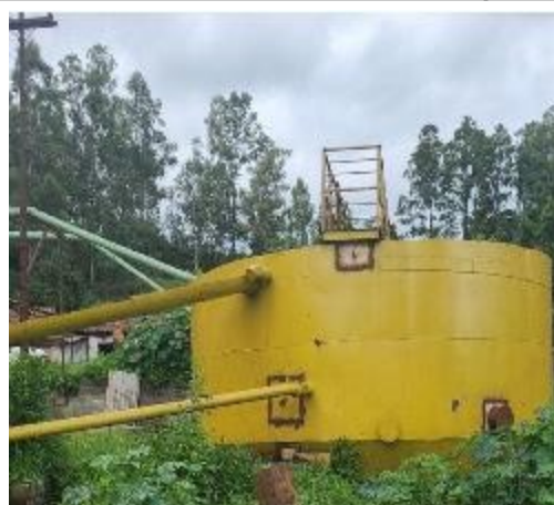
Foto 06. Tanque de recirculação de água.
